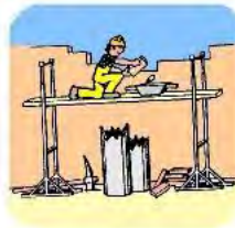
Fig. 11: Falta de orden y limpieza
