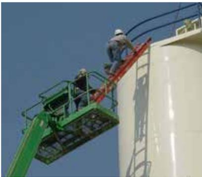
Figura 10. Acceso a una estructura utilizando medios auxiliares
