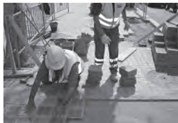
Figura 2. Trabajo en zanjas medianas
